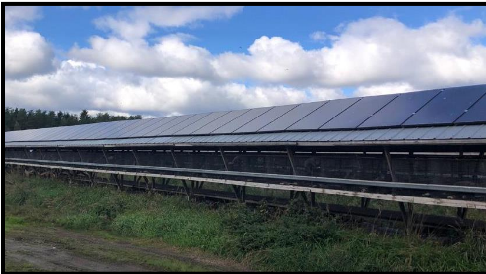
Kuva: Hannu Kärjä. Varjotalojen kattopinta-alaa voi hyödyntää mm. aurinkoenergian tuottamiseen.
