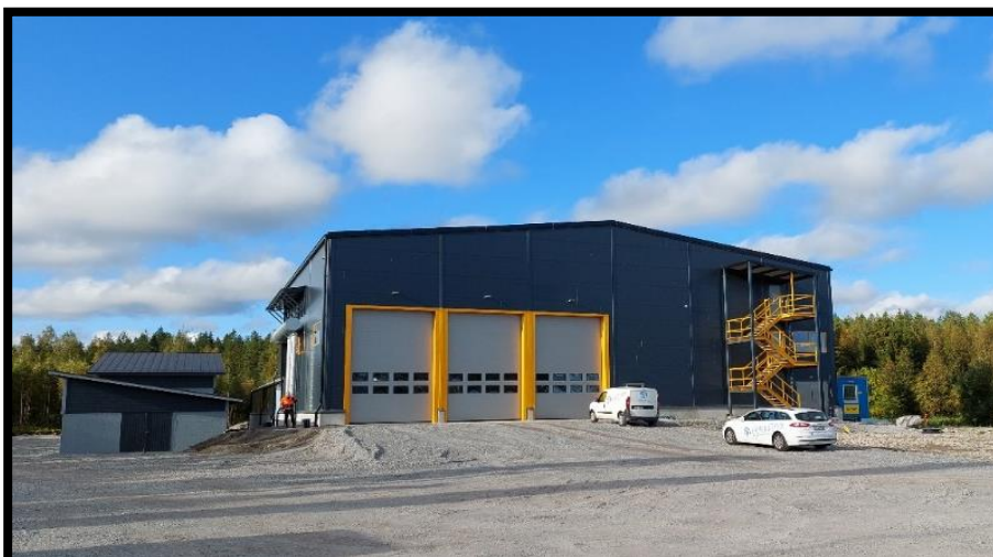
Bild: Doranova Oy. Torröttningsanläggning, Jeppo Biogas Ab.
