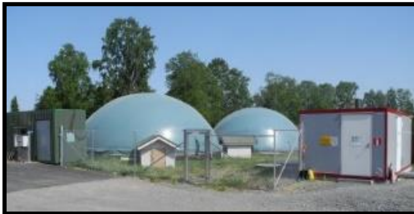
Bild: Johanna Laakso. Biogasanläggning.
